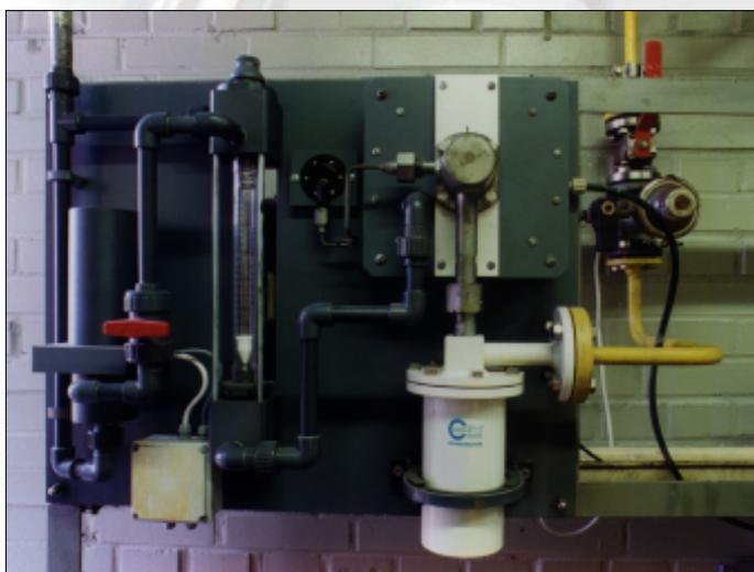
Хлоратор MR 50 RC дополнительно оборудуется электродвигательным клапаном
