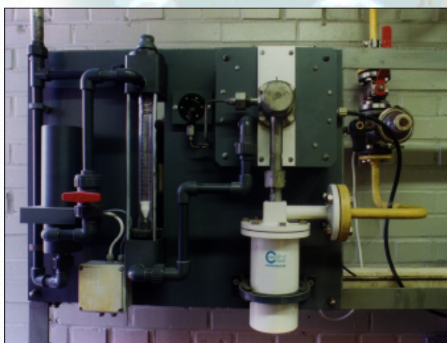
Хлоратор MR 40 RC дополнительно оборудуется электродвигательным клапаном
